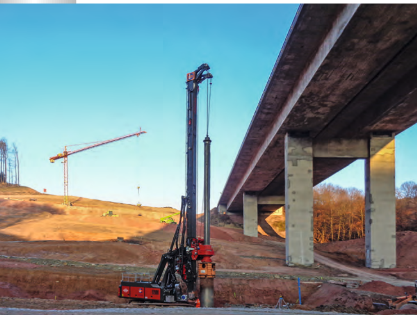
Schwierige topographische Verhältnisse beim sechsspurigen Ausbau der A3 im Spessart
