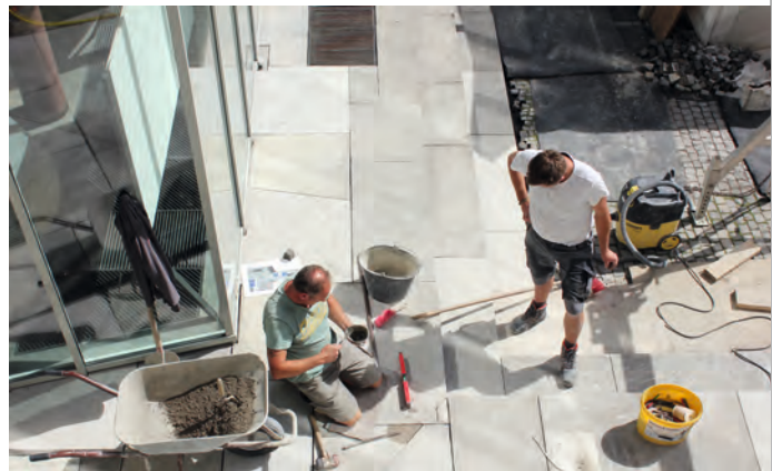
Austausch abgeschlossen – die letzte Muschelkalkplatte wird eingesetzt
